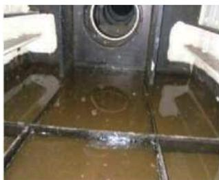
マンホール蓋自体が腐食し、鋼製橋脚内の滞水・腐食の原因に。
