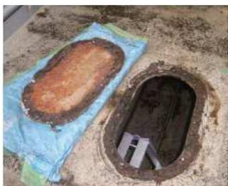
マンホール蓋のボルトの隙間やマンホール蓋と橋脚面の隙間に雨水が浸入。
