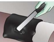
パテナイフやヘラなどで、補修する部分の上、及び周辺に厚めに塗り広げます。冬期など気温が低いと硬化時間が長くなります。投光器や工業用ドライヤーなどで加温することで、硬化を促進させることができます。
