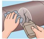
ケレン処理が終了したら、速やかに脱脂処理を行います。油やその他異物はたいてい表面下に染み込んでいるので、アセトン、MEK(メチルエチルケトン)など揮発性の高い溶剤を用いて脱脂処理を行って下さい。
