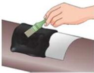
付属の刷毛で、補修する部分全体に厚めに塗り広げます。冬期など気温が低いと硬化時間が長くなります。投光器や工業用ドライヤーなどで加温することで、硬化を促進させることができます。
