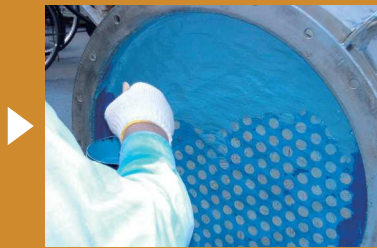
補修 ブラッシュアップセラミックとセラミックリペアーを使用して、チューブ式熱交換器管板面の恒久的な補修ができる。
