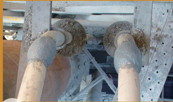
補修 廃プラスチックが当たり、穴が開いている配管のエルボー部を、ファインロード300で補修。
